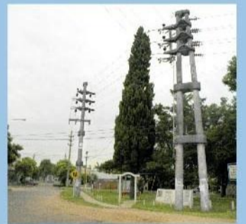
En Belgrano y Constitución se instaló un seccionador bajo carga para reenviar el alimentador N°3 hacia el Anexo II.
